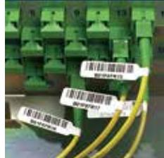
細径の光ファイバーケーブルの識別に。接着面を小さくしたストレスフリーな形状。巻付けだけでなく、旗状に貼り付ける形状もあります。
